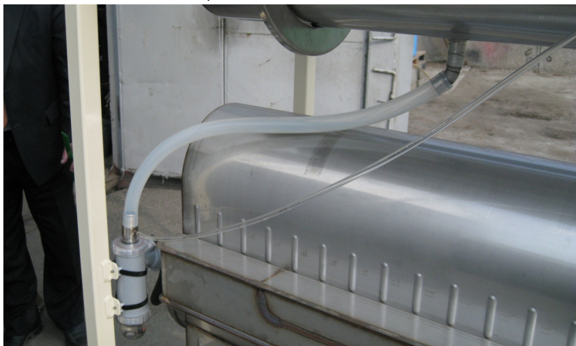
Рис. Отвод конденсата в дренаж
